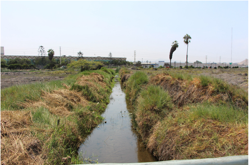
Fig. 16. Canales de drenaje que atraviesan los pantanos.
